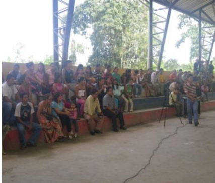
Cancha cubierta de Yutzupino.
